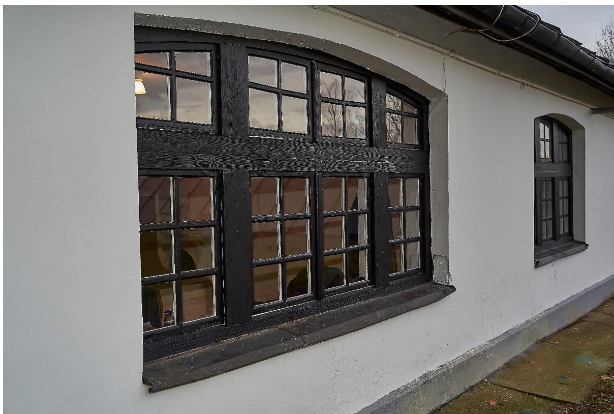
Fot. Okna po remoncie
