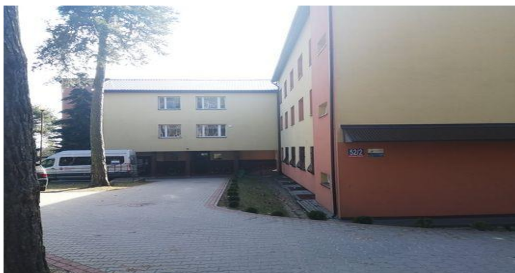
Fot. Po czyszczeniu budynku
