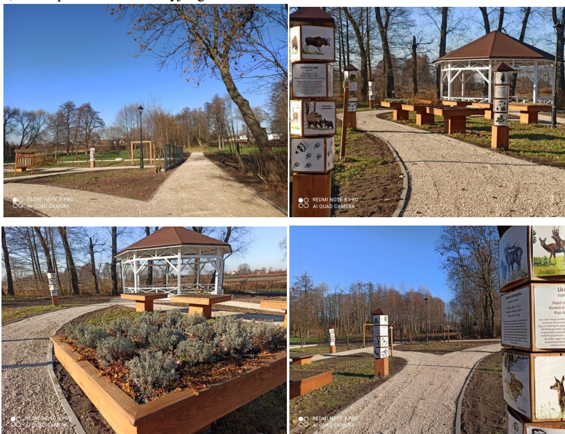
Fot. Wykonanie alejek szutrowych i nasadzenia zieleni
