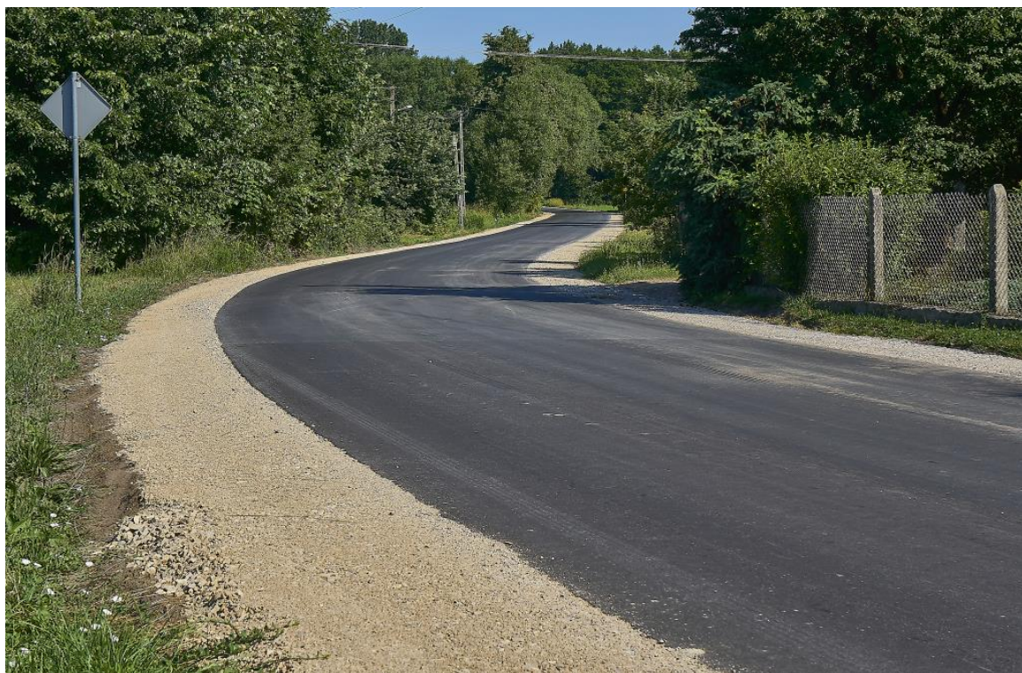
Fot. Droga powiatowa nr 3628W w miejscowości Rogóziec
