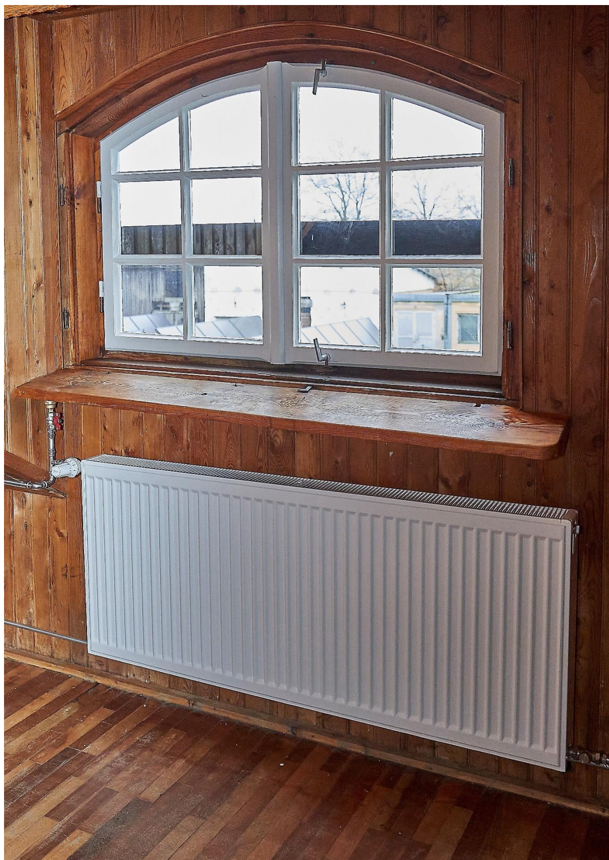
Fot. Remont okien i wymiana instalacji c.o.
