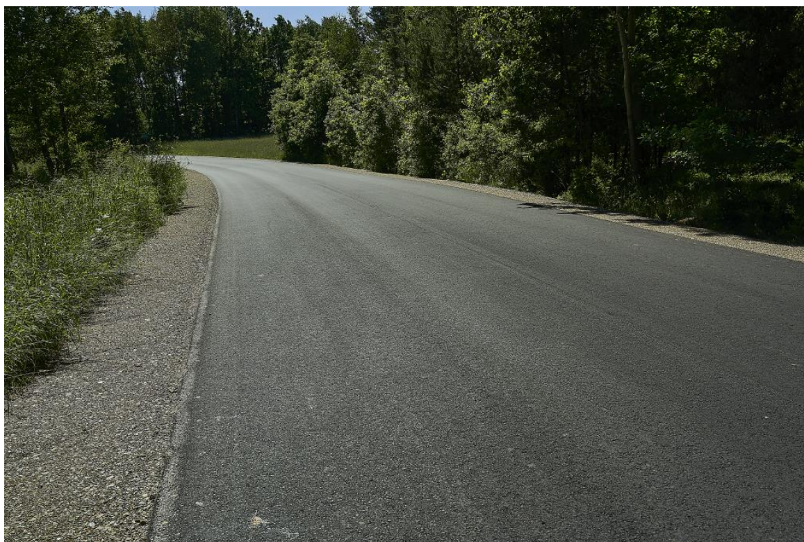
Fot. Droga powiatowa nr 3546W Dąbrówka Stany – Klódzie
