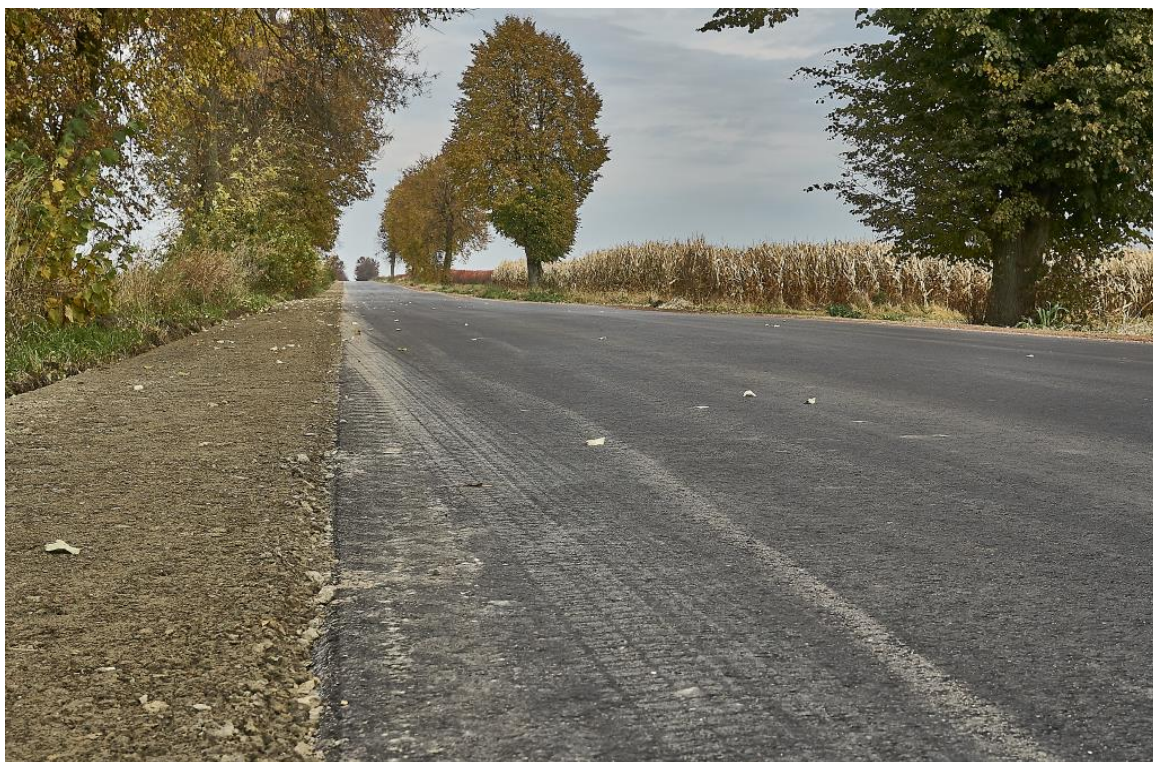
Fot. Droga powiatowa nr 3667W Krzesk Majątek – Kośmidry
