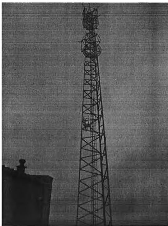
Zał. nr 1: Widok ogólny instalacji radiokomunikacyjnej.
