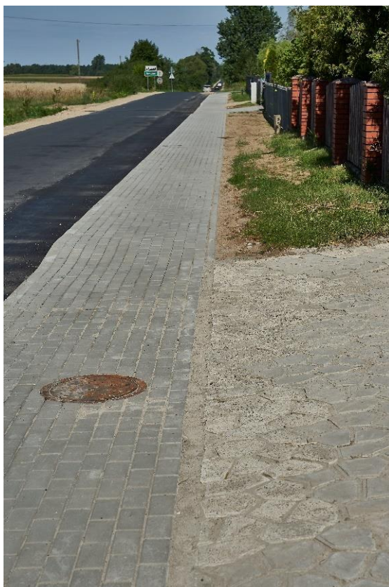
Fot. Chodnik w ciągu drogi powiatowej nr 2258W w m. Seroczyn
