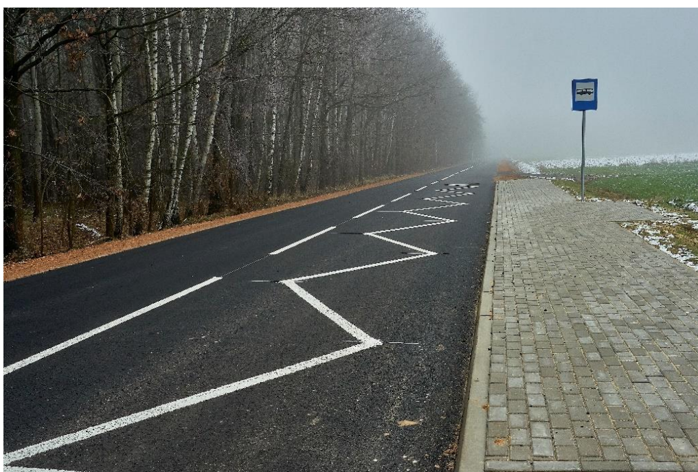
Fot. Droga powiatowa nr 3664W na odcinku od m. Łęczycki do m. Przesmyki
