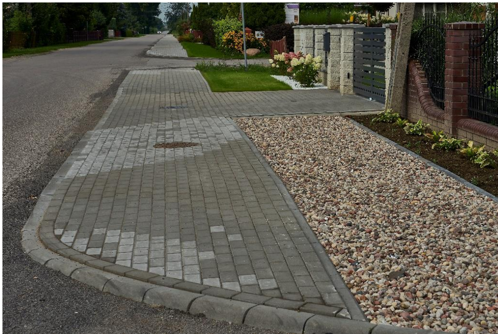
Fot. Chodnik w ciągu drogi powiatowej nr 3667W w m. Krzesk-Majątek
