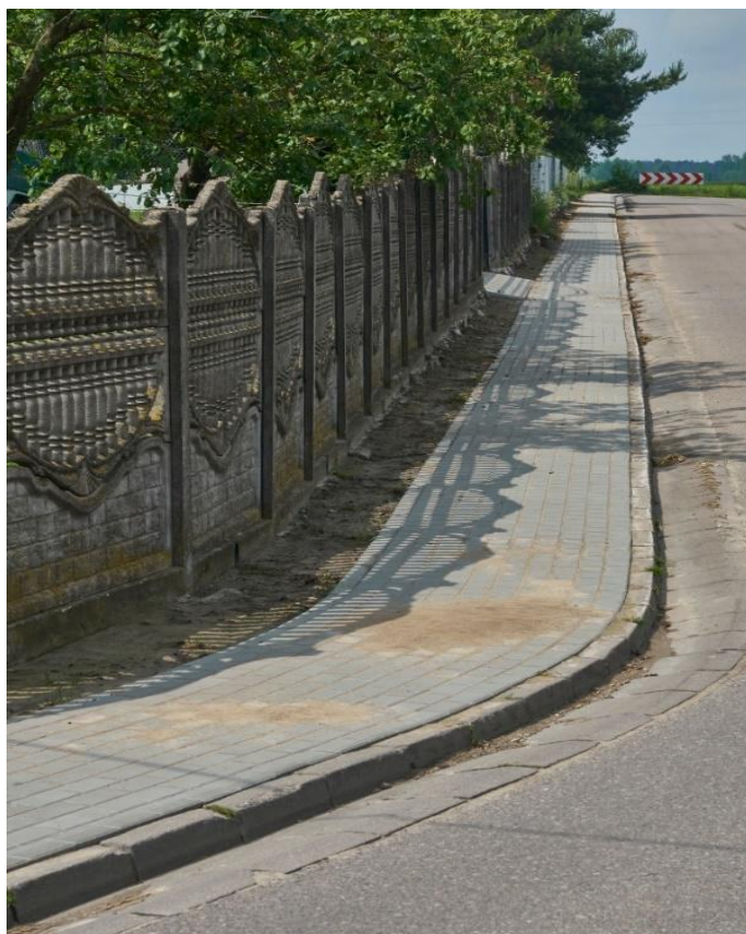
Fot. Chodnik w ciągu drogi powiatowej nr 3662W w m. Zaliwie Piegawki
