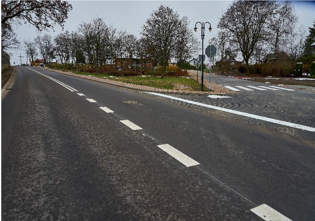
Fot. Droga powiatowa nr 3934W w m. Korczew
