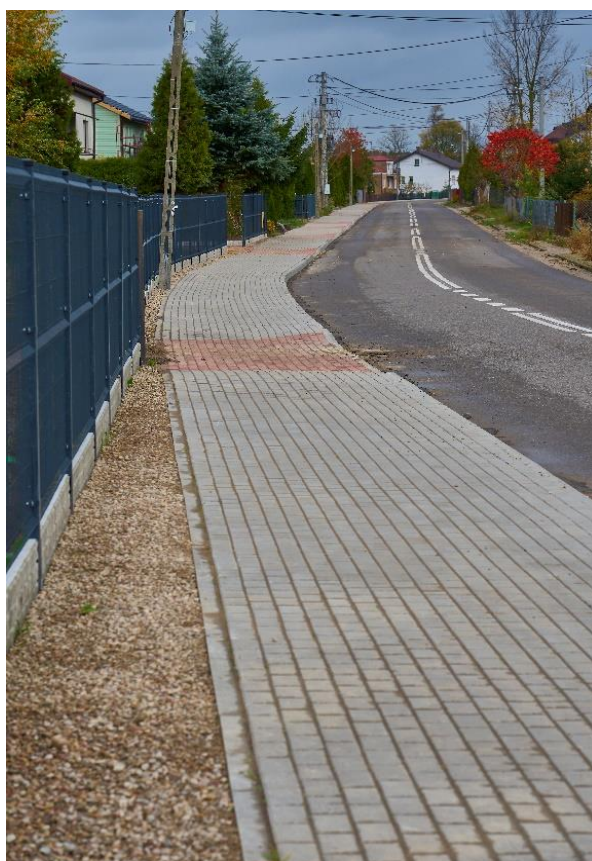
Fot. Chodnik w ciągu drogi powiatowej nr 3612W w m. Podnieśno
