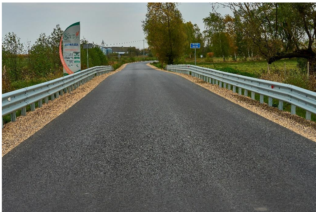
Fot. Droga powiatowa nr 3615W na odcinku od skrzyżowania z drogą powiatową nr 3615W do m. Mordy
