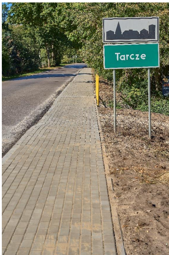
Fot. Chodnik w ciągu drogi powiatowej nr 3666W w m. Tarcze
