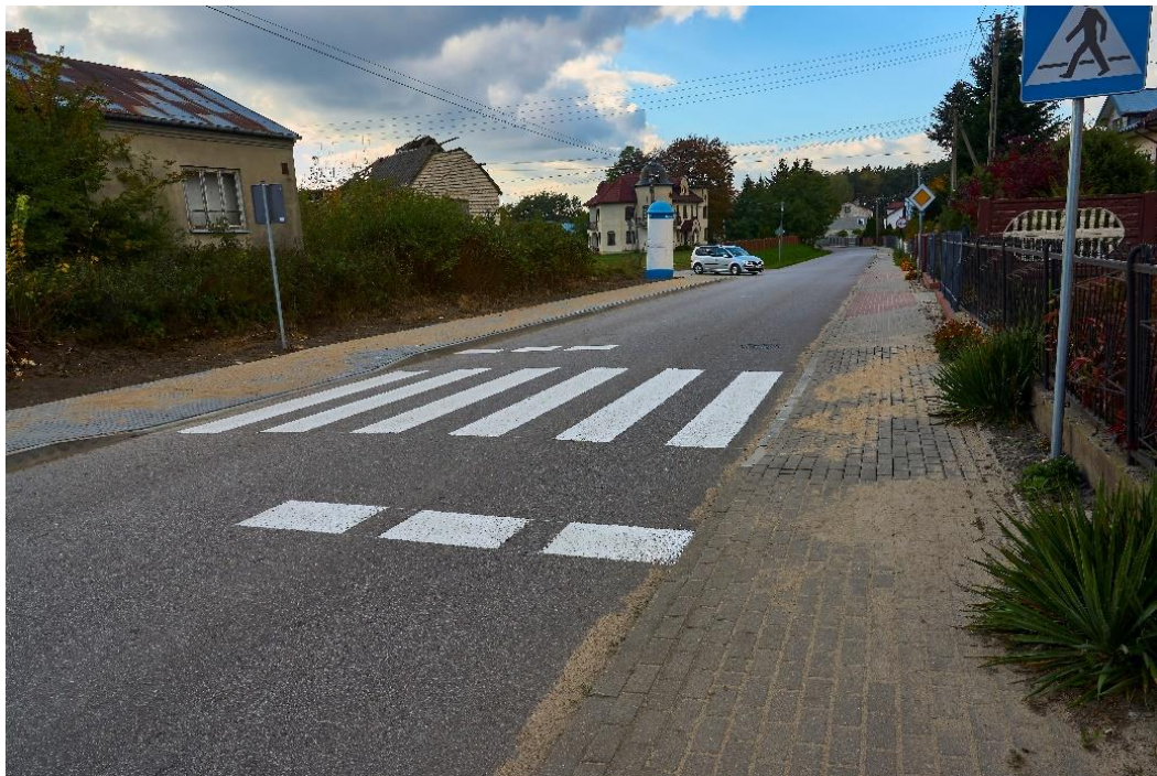
Fot. Przejście dla pieszych w ciągu drogi powiatowej nr 3645W w m. Czerniejew
