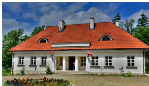
Fotografia 26. Widok na dwór w Dąbrowie.
