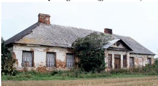
Fotografia 35. Widok na dwór w Nowych Iganiach.
