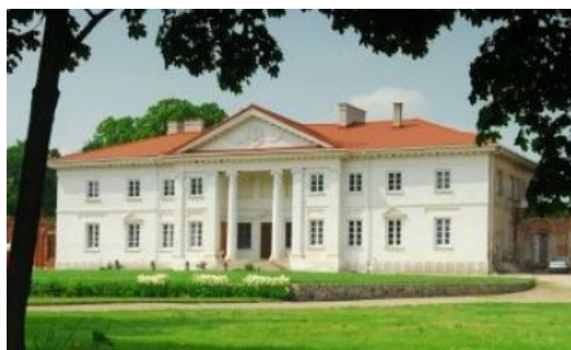
Fotografia 21. Widok na pałac w Korczewie (zdjęcie wykonane przed pożarem dachu).
