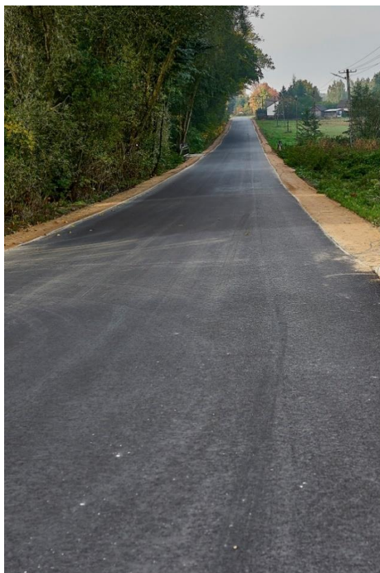
Fot. Droga powiatowa nr 3606W na odcinku od m. Stara Dąbrówka do m. Cisie-Zagrudzie
