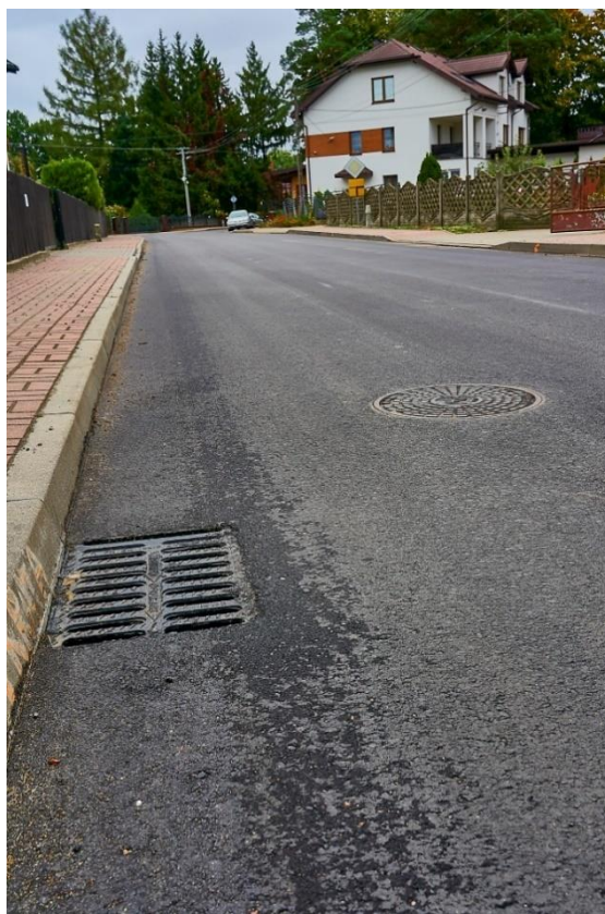
Fot. Droga powiatowa nr 3652W w m. Domanice
