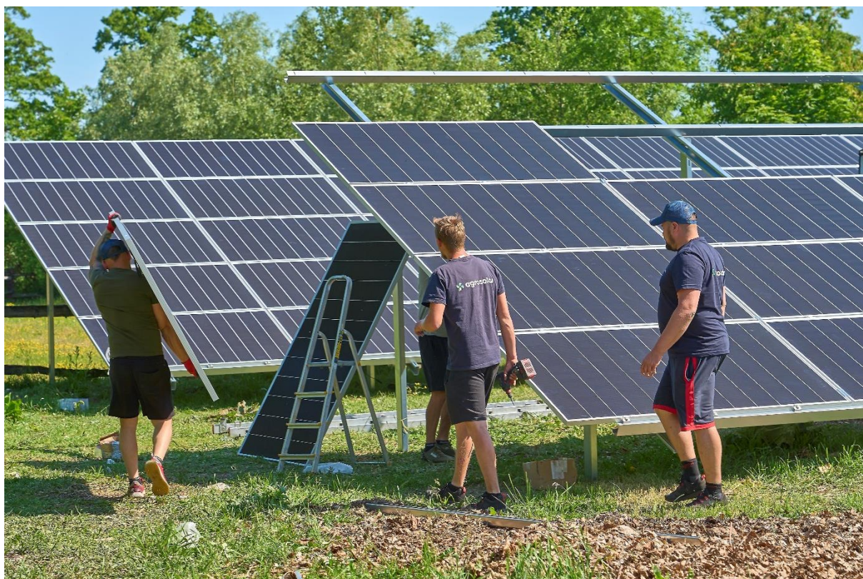
Fot. Budowa instalacji fotowoltaicznej
