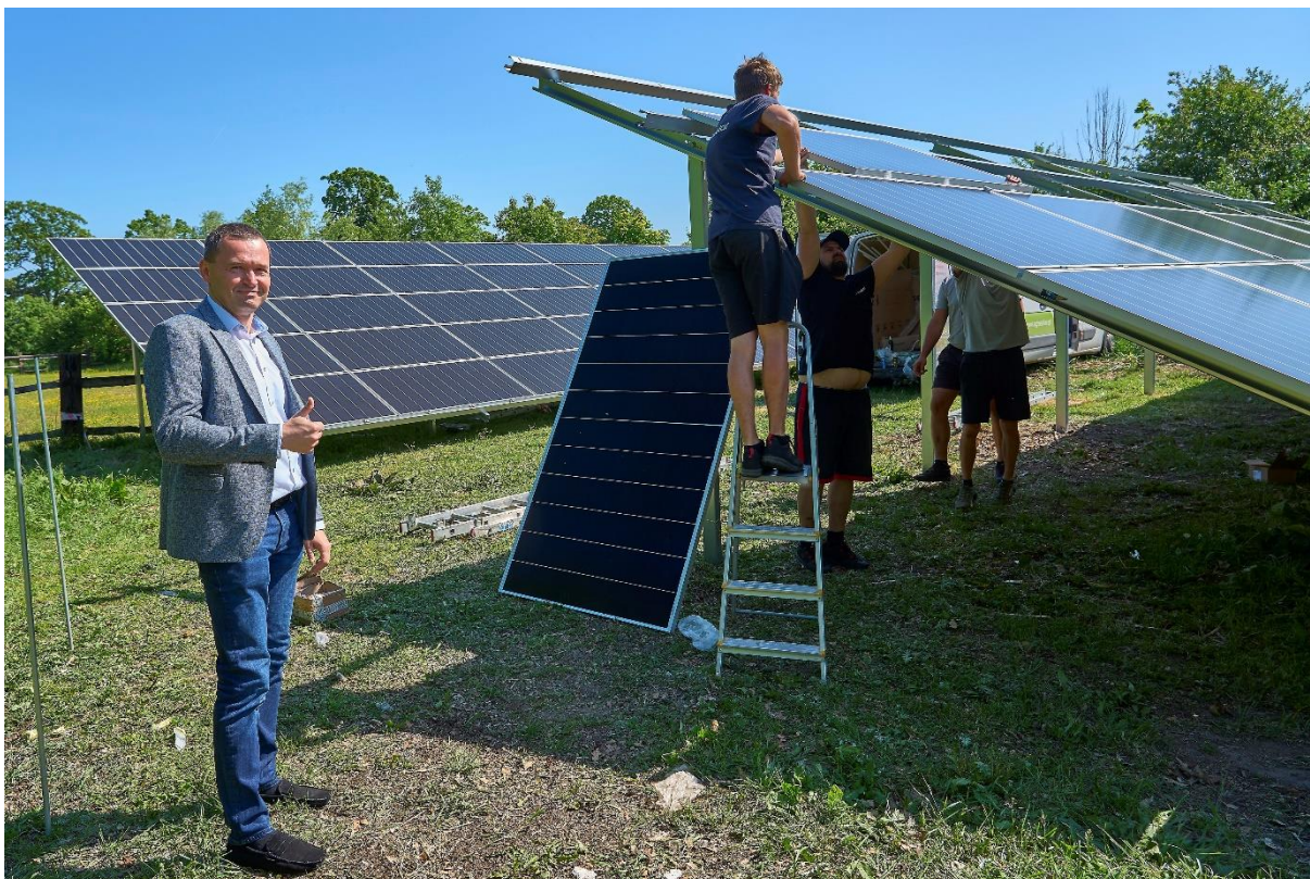
Fot. Budowa instalacji fotowoltaicznej
