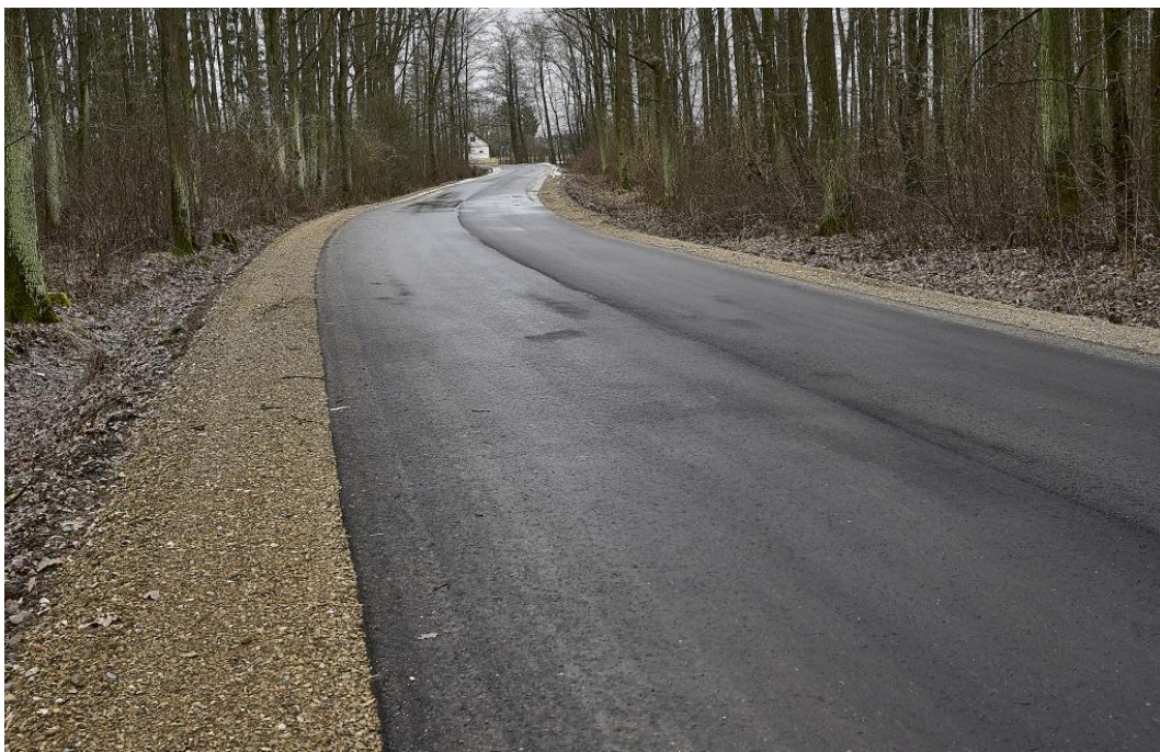
Fot. Droga powiatowa nr 3640W w m. Zbuczyn
