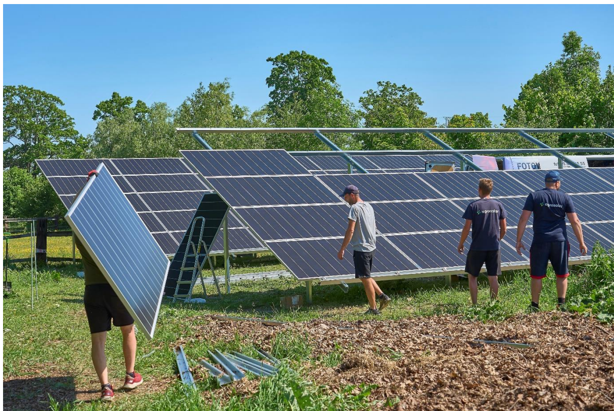
Fot. Budowa instalacji fotowoltaicznej
