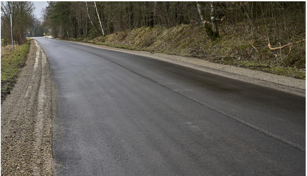
Fot. Droga powiatowa nr 3666W w m. Ostoje
