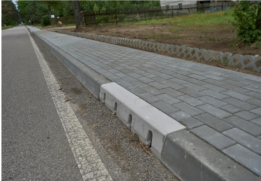
Fot. Droga powiatowa nr 3663W w m. Góry (nowa droga dla pieszych)
