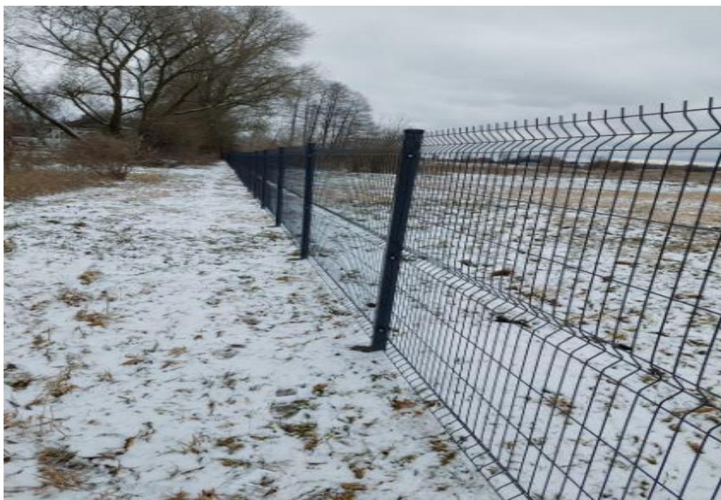
Fot. Północno-zachodnia część ogrodzenia obwodowego.
