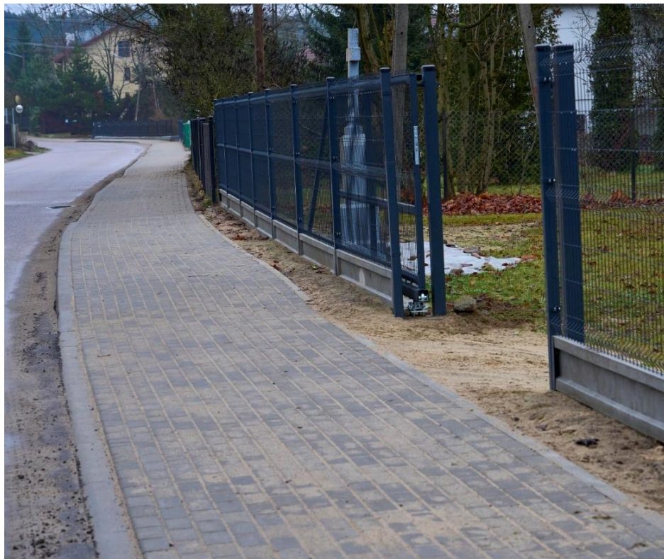
Fot. Droga powiatowa nr 3608W w m. Kieselany-Żmichy (nowa droga dla pieszych)
