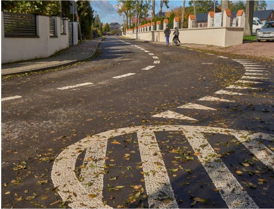
Fot. Droga powiatowa nr 3661W w m. Mokobody (ul. plac Chreptowicza i ul. Cmentarna - nowa nawierzchnia jezdni)
