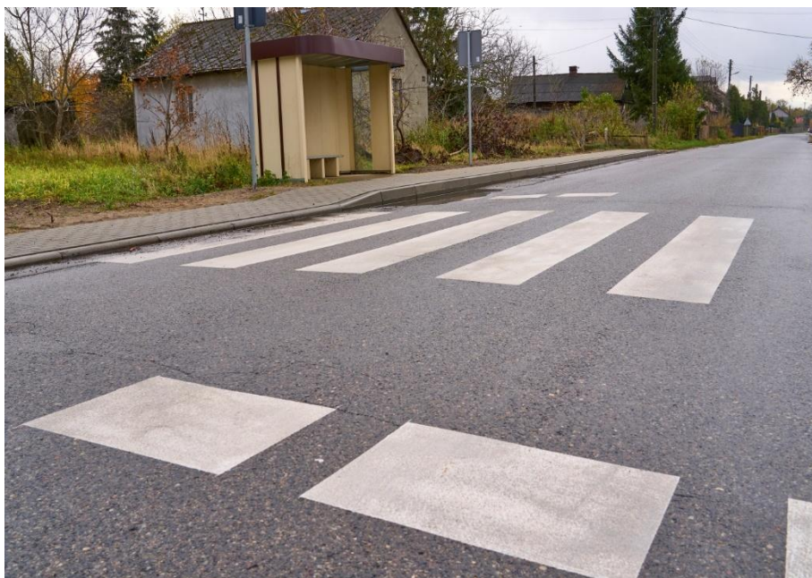
Fot. Droga powiatowa nr 3657W w m. Smolanka (nowe perony i przejścia dla pieszych)
