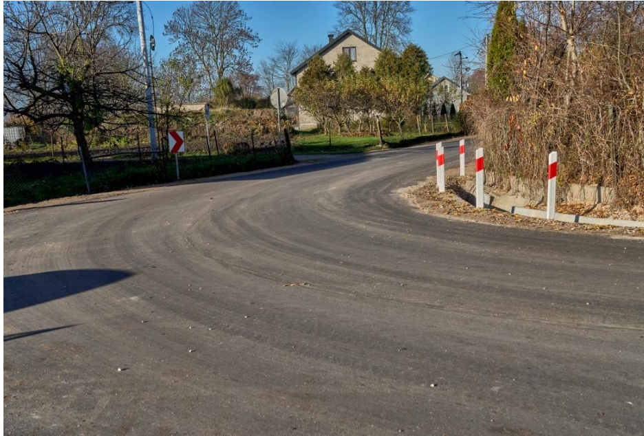
Fot. Droga powiatowa nr 3627W w m. Cierpigórz (nowa nawierzchnia jezdni)
