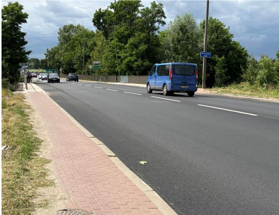
Fot. Droga powiatowa nr 3644W w m. Nowe Iganie (obiekt mostowy)
