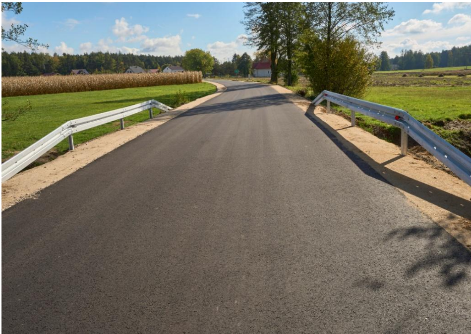
Fot. Droga powiatowa nr 3626W na odcinku od m. Paprotnia do m. Pluty (nowa nawierzchnia jezdni)
