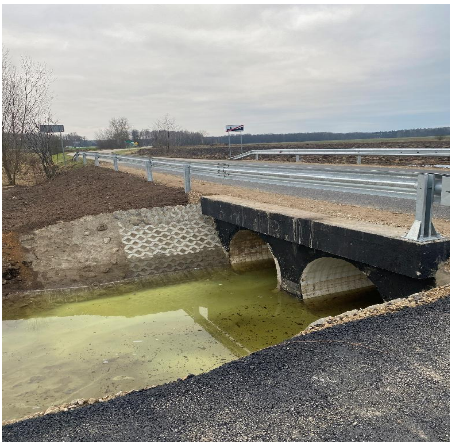
Fot. Droga powiatowa nr 3612W w m. Podnieśno (odwodnienie)
