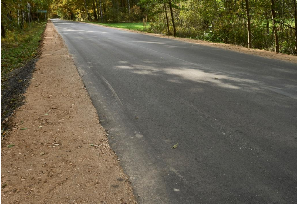
Fot. Droga powiatowa nr 3634W na odcinku od m. Wólka Wiśniewska w kierunku m. Myrcha (nowa nawierzchnia jezdni)
