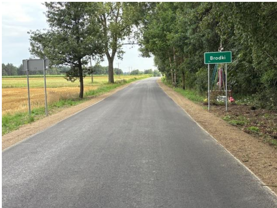
Fot. Droga powiatowa nr 2259W na odcinku od m. Brodki do granicy powiatu (nowa nawierzchnia jezdni)
