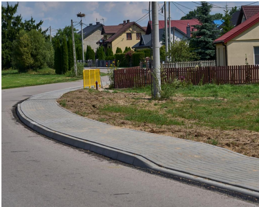
Fot. Droga powiatowa nr 3675W w m. Józefin (nowa droga dla pieszych)
