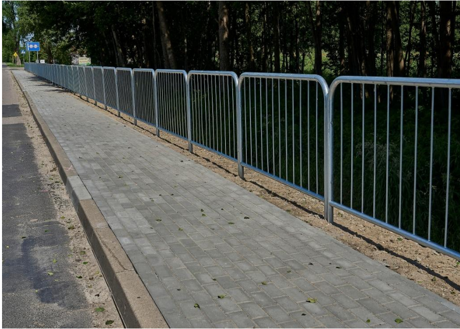
Fot. Droga powiatowa nr 3608W w m. Niwiski (nowa droga dla pieszych)
