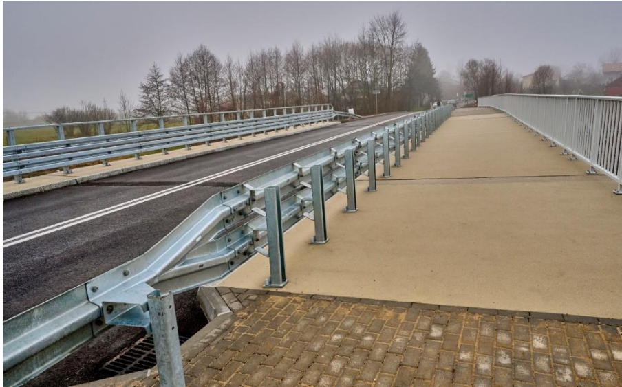
Fot. Droga powiatowa nr 3615W w m. Kownaciska (nowy obiekt mostowy)
