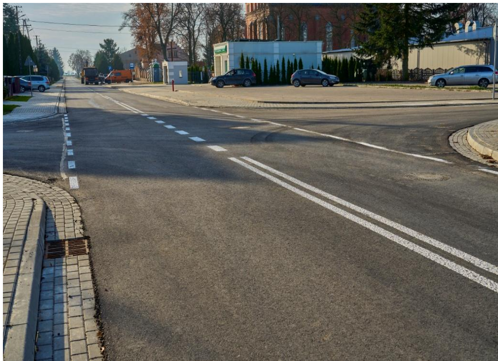
Fot. Droga powiatowa nr 3667W w m. Krzesk-Majątek (nowa nawierzchnia jezdni, droga dla pieszych, odwodnienie – kanalizacja deszczowa, rowy)
