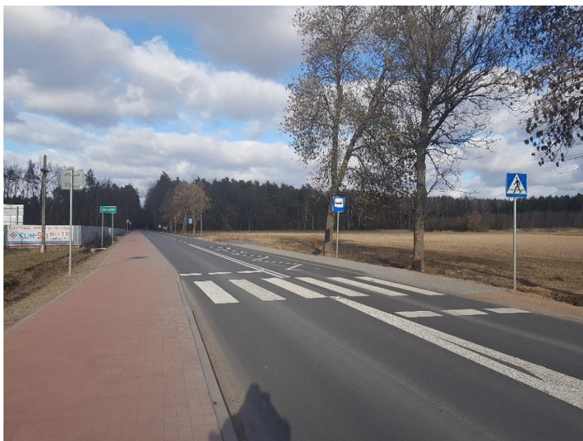
Droga powiatowa nr 3617W Siedlce – Korczew na odcinku granica m. Siedlce – Golice
