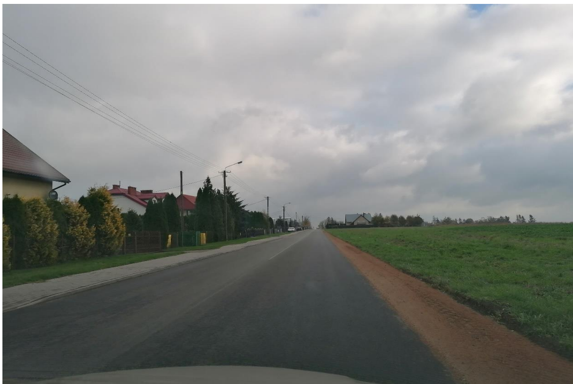
Fot. Droga powiatowa nr 3614W Suchożebry – Brzozów
