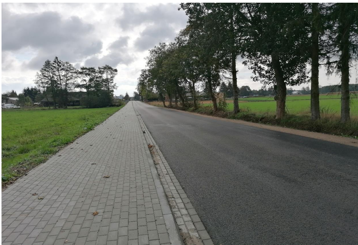
Fot. Droga powiatowa nr 3638W – ul. Klonowa w Zbuczynie
