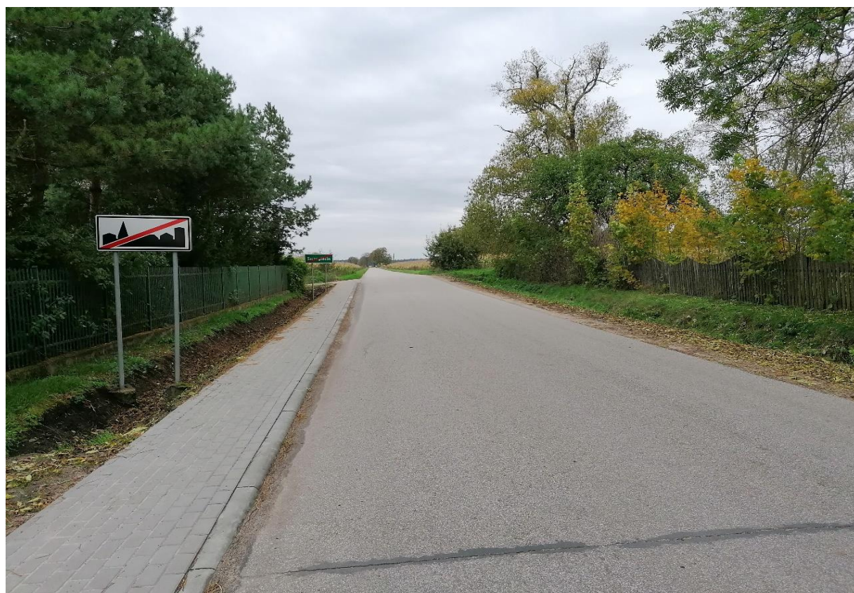
Fot. Chodnik w miejscowości Szczeglacin
