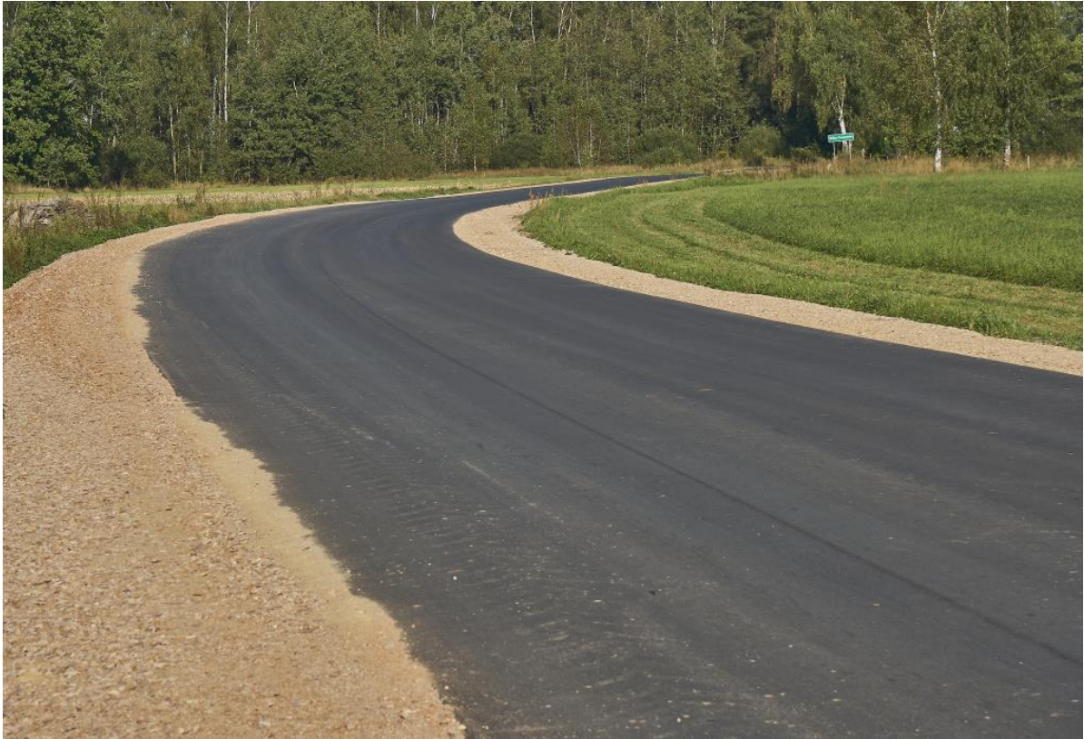
Fot. Droga powiatowa nr 3661W w miejscowości Zaliwie-Szpinki
