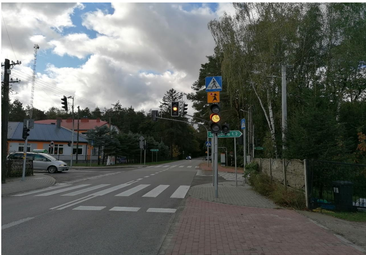
Fot. Sygnalizacja świetlna na skrzyżowaniu dróg powiatowych w miejscowości Golice
