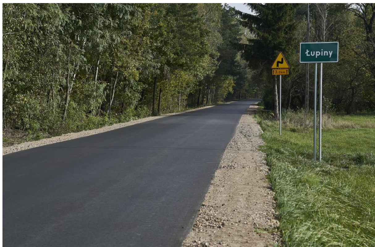
Fot. Droga powiatowa nr 3654W Kaczory – Łupiny – Domanice
